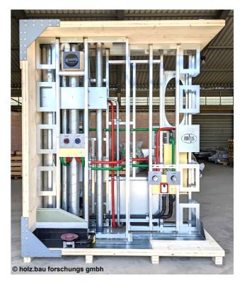
Fotos: Mockup einer holzbauadäguaten Sanitärinstallation
